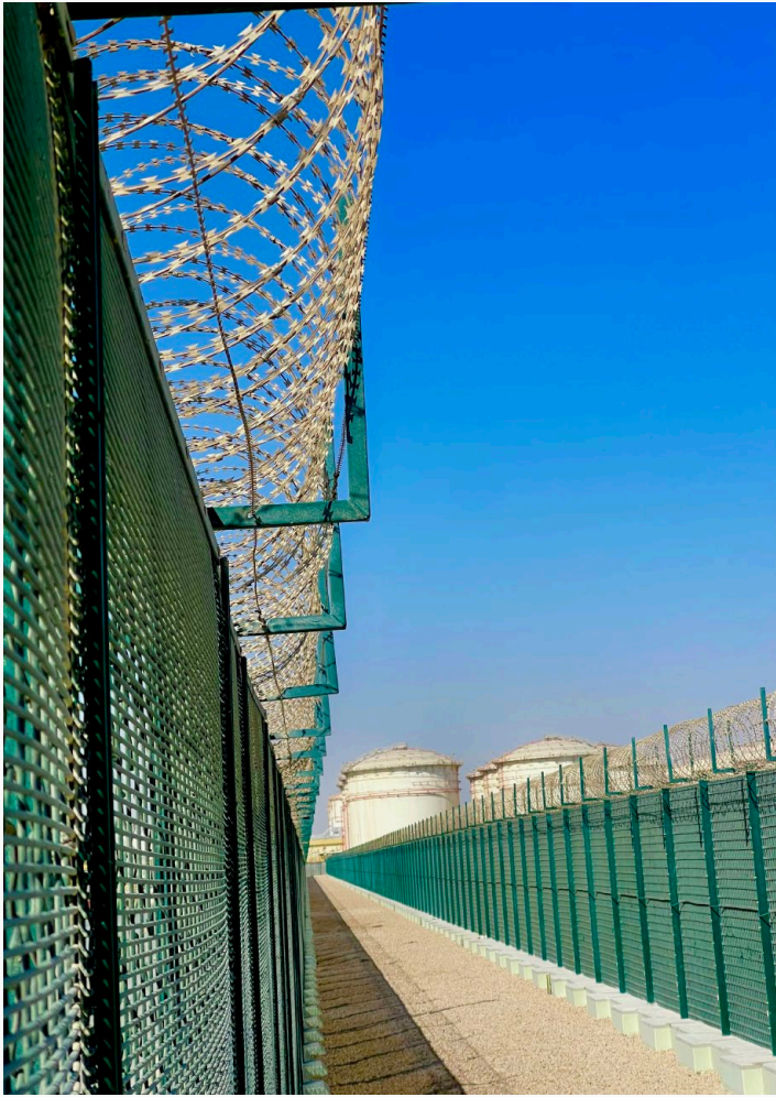
ROP 1 min, 10 min, ISPS Fence Installation
